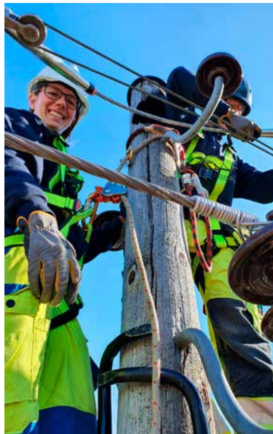
Malin och Bertil lagar en skadad luftledning – något som blir mer och mer sällsynt eftersom en större del av vårt elnät består av markförlagd elkabel.
